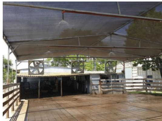
Ejemplo de subsombreado con ventilación forzada y humidificación por lluvia.
