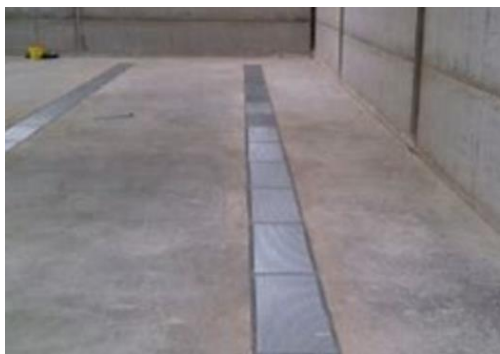
Canal de ventilación
